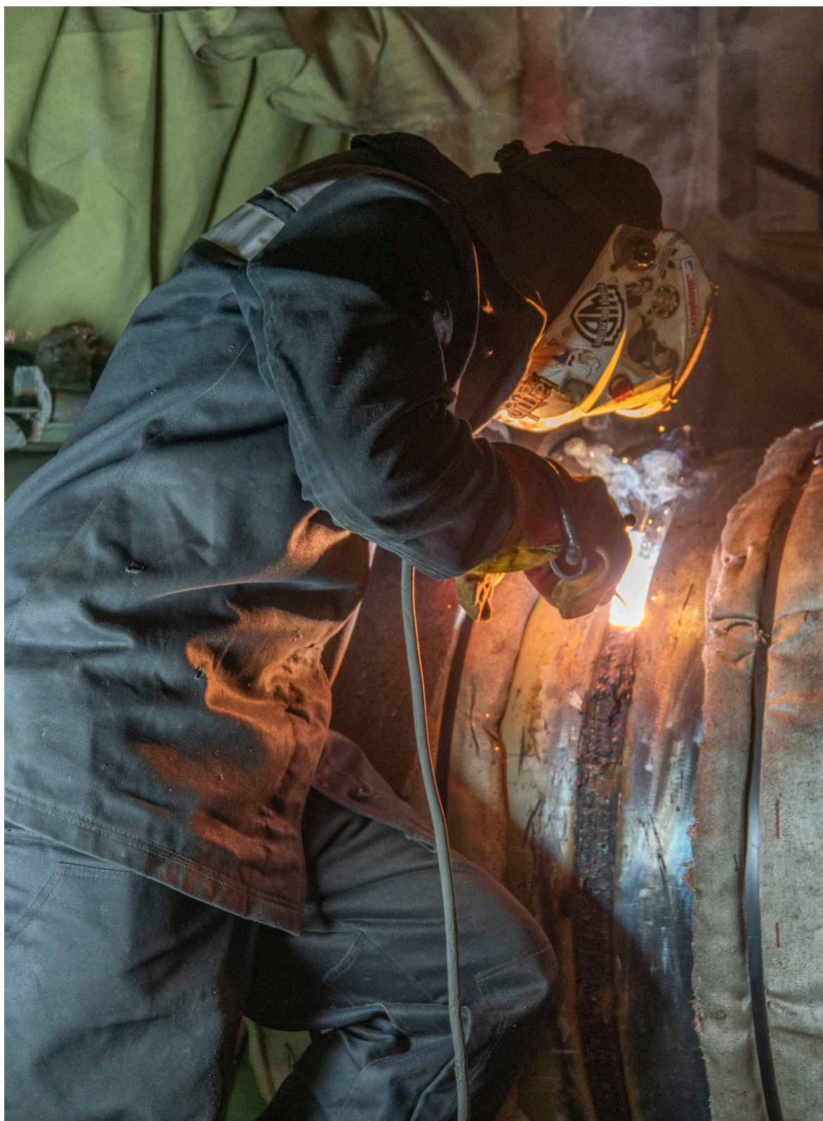
▲ Сварка главного циркуляционного трубопровода (ГЦТ) на энергоблоке №1 Курской АЭС-2
