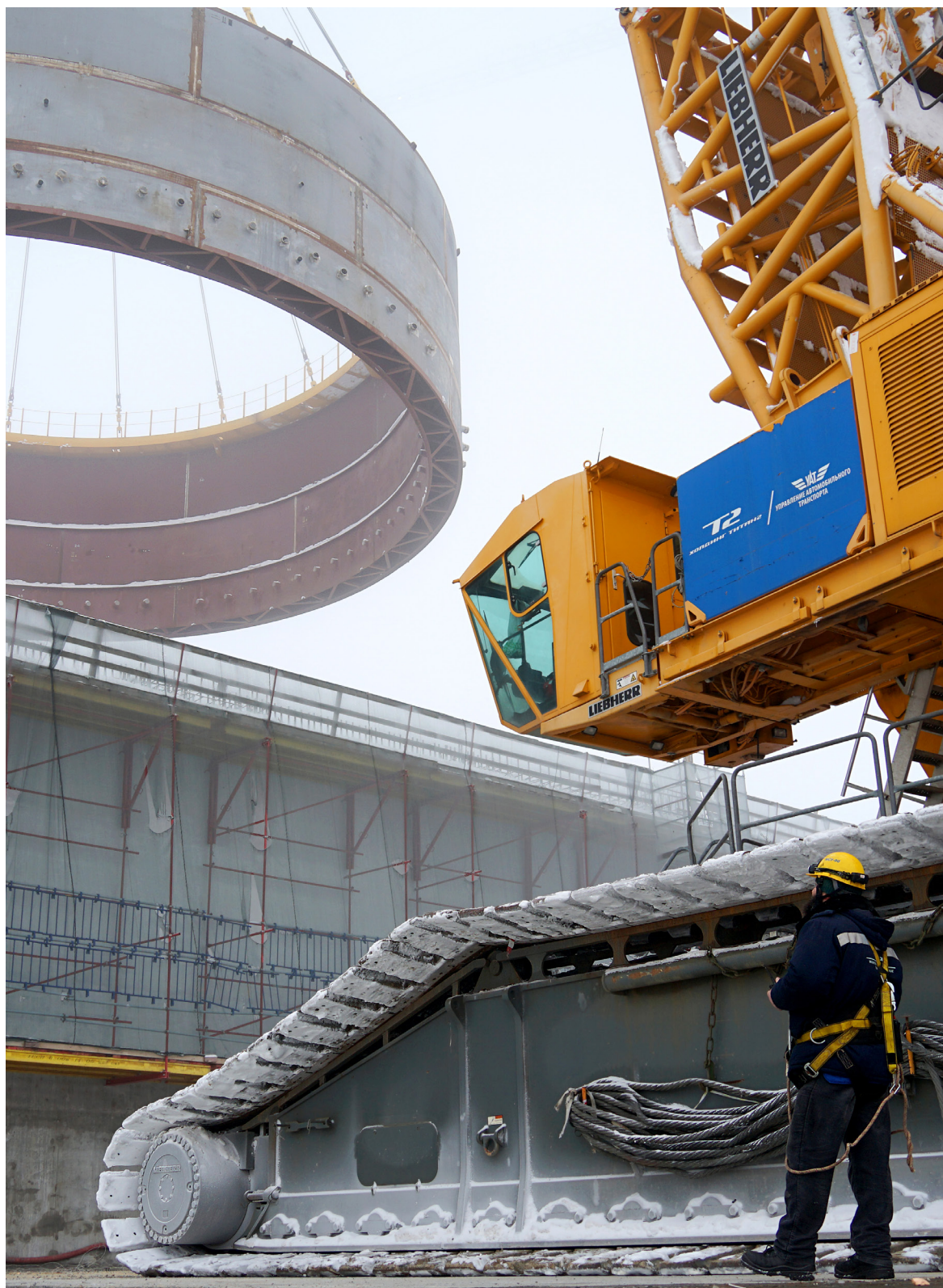
▲ Установка стальной опорной плиты реактора БРЕСТ-ОД-300 общим весом 165 тонн
