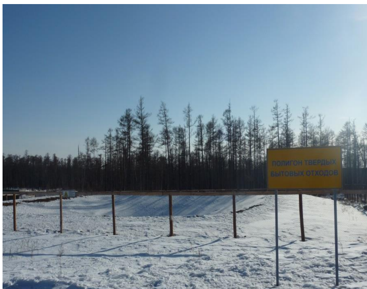
Фото 12. Полигон ТБО (секция № 2)
