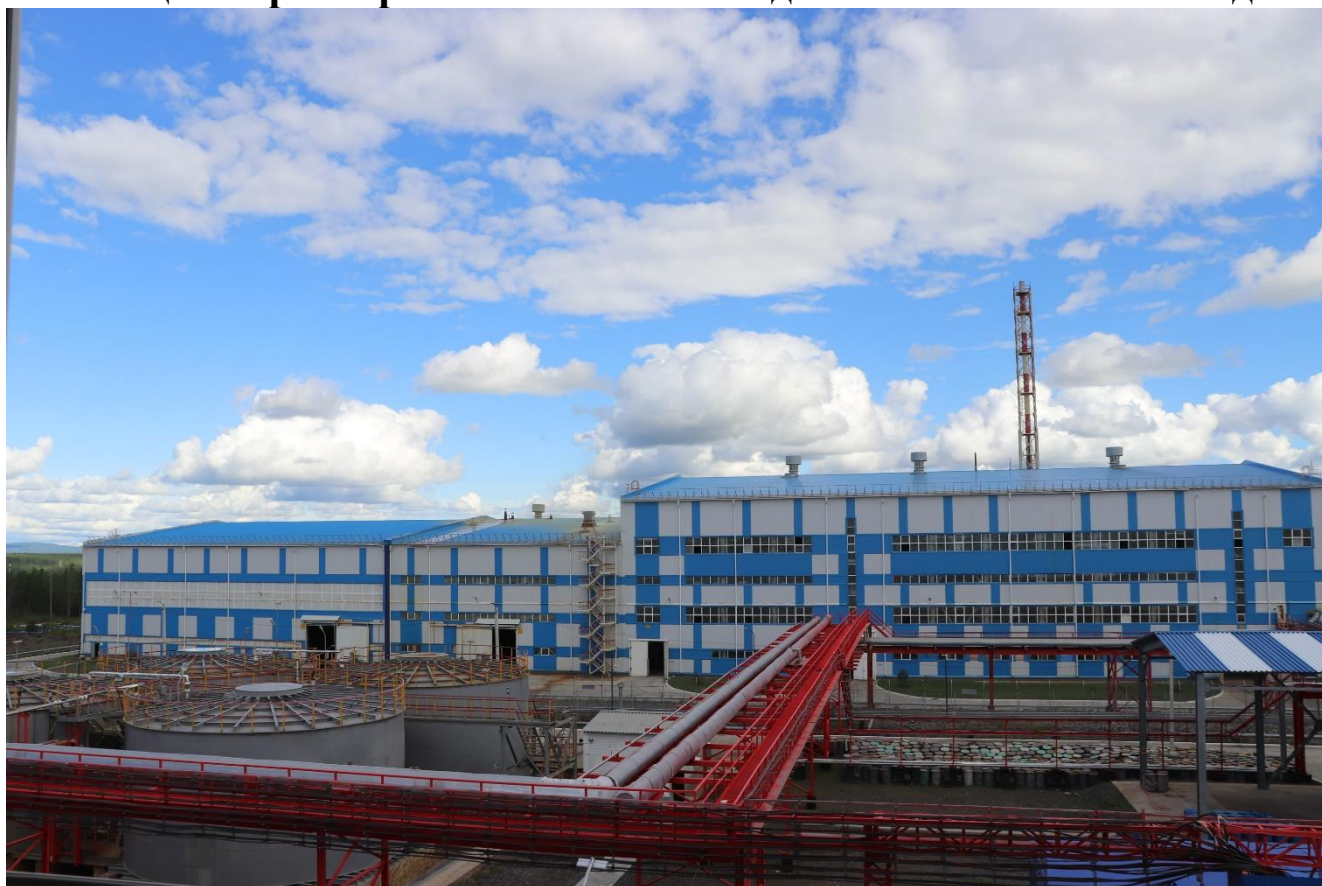
Фото 1. Главный корпус центральной производственной площадки (ЦПП) цеха подземного выщелачивания АО «Хиагда»
