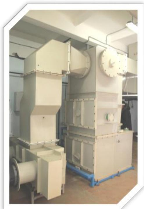
Установки предназначены для улавливания пыли пластмасс, абразивной и металлической, имеющие степени очистки 80-90%.
