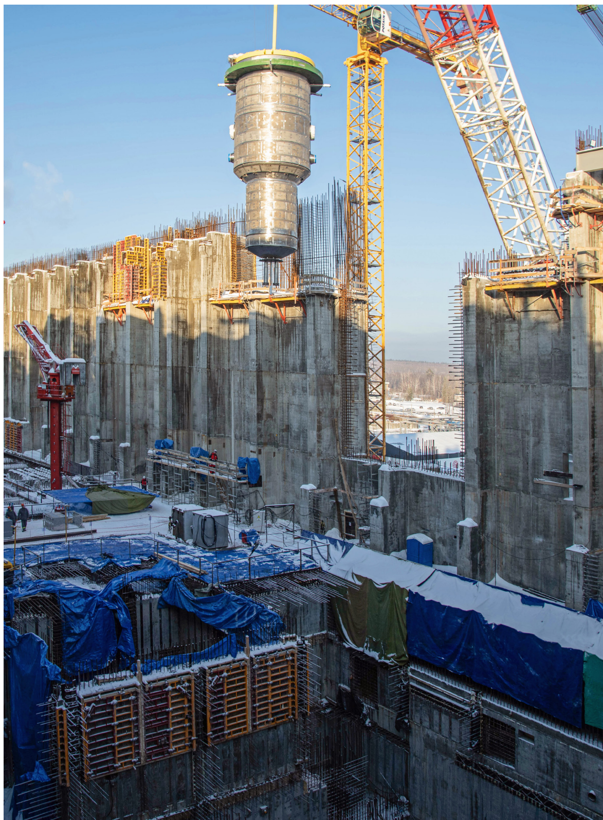
▲ Монтаж корпуса реактора МБИР
