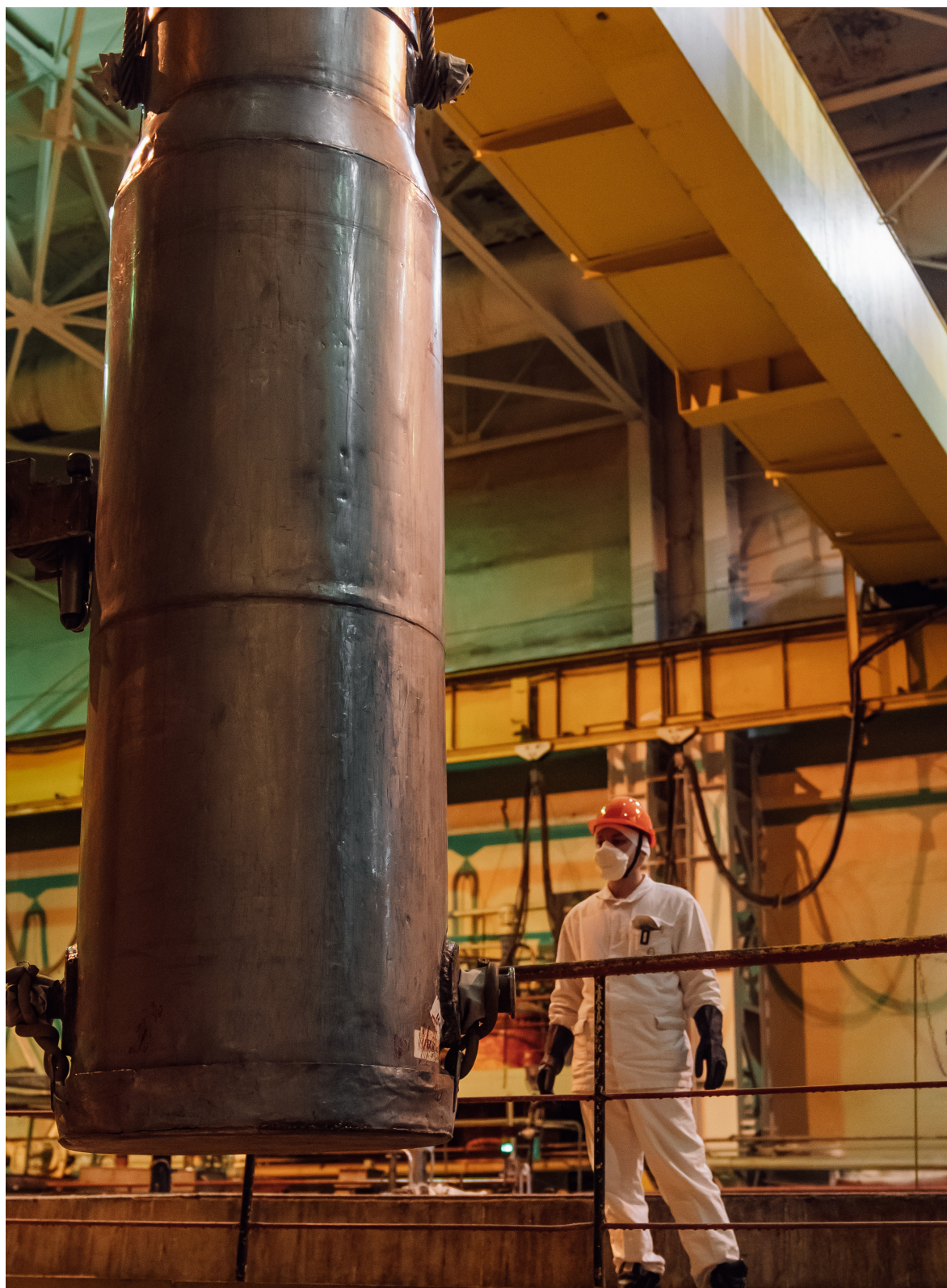
▲ Проведение работ в центральном зале реакторной установки БОР-60
