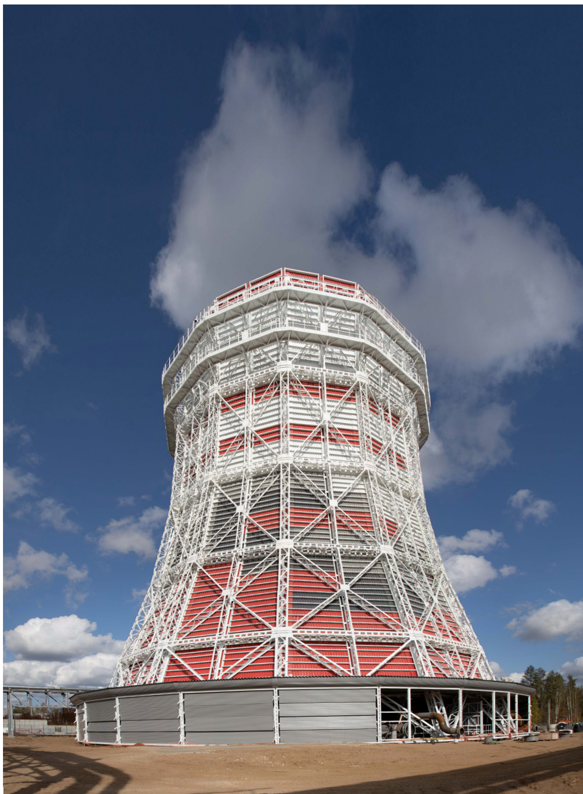
▲ Монтаж оборудования градирни МБИР
