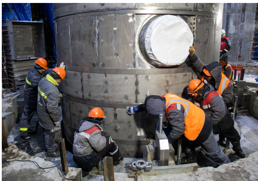
► Монтаж корпуса реактора МБИР
