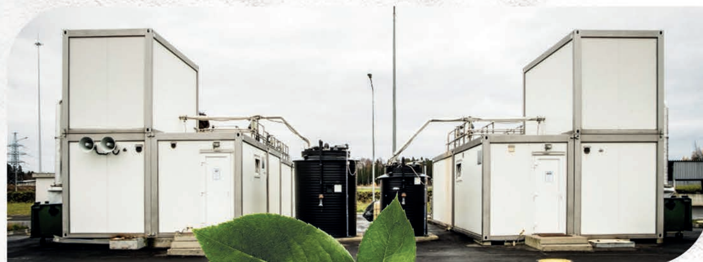
Очистные сооружения на площадке Ленинградской АЭС-2
