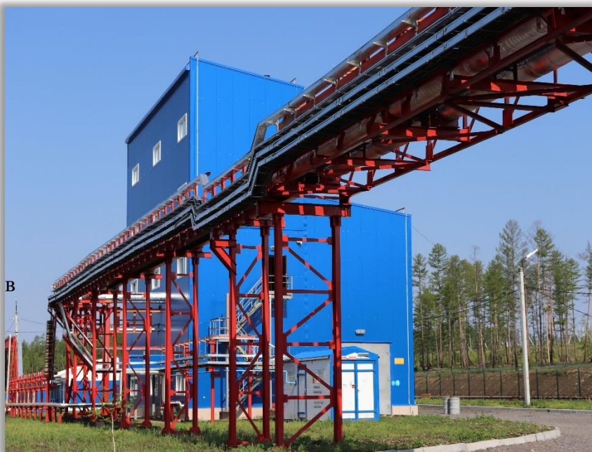
Фото 3. ЛСУ месторождения Источное
